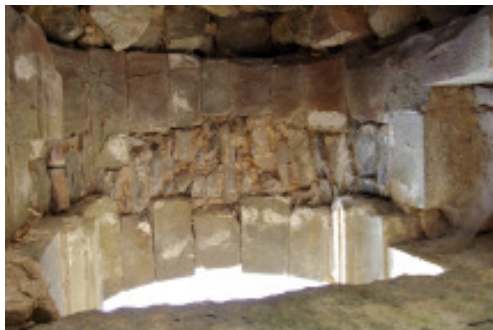
Fig. 6 - Muratura a sacco che caratterizza l'intera fabrica lucchese.
