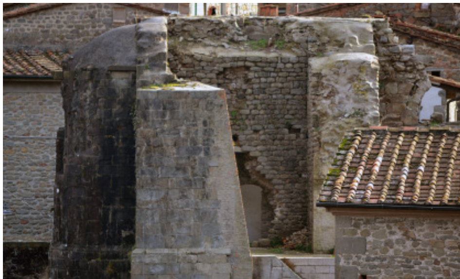
Fig. 16 - Torre fiorentina addossata all'abside della chiesa lucchese.
