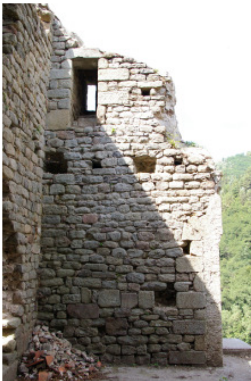
Fig. 14 - Resti della torre fiorentina costruita all'interno della navata della chiesa di S. Matteo.
